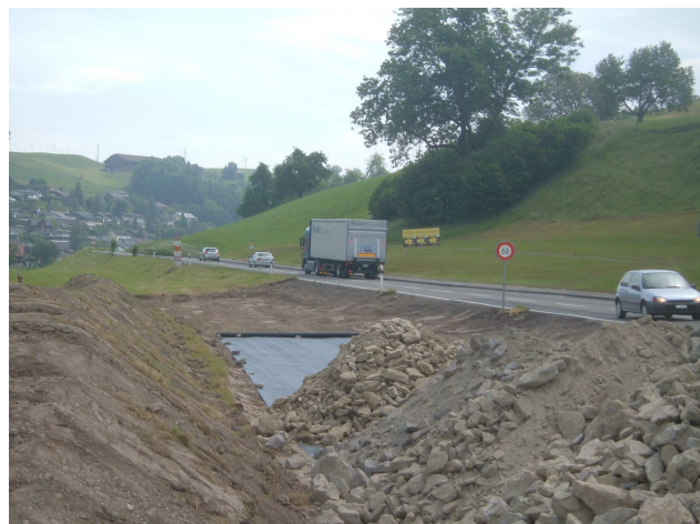
Bild: Ebikonerstrasse von Stuben Richtung Widspüel-Kreisel
