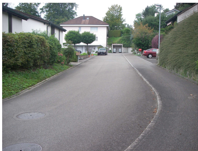
Bild: Quartierstrasse Angelmatte
